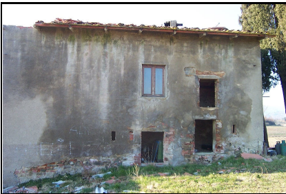
Foto: 07 Data ripresa: 14/02/2006 Edificio: 235/A File: 235-07.JPG
