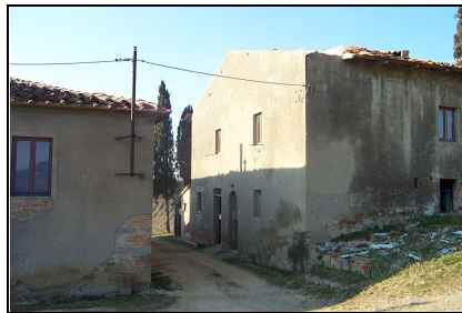
Foto: 05 Data ripresa: 14/02/2006 Edificio: 235/A File: 235-05.JPG
