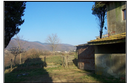
Foto: 09 Data ripresa: 14/02/2006 Edificio: 235/A File: 235-09.JPG
