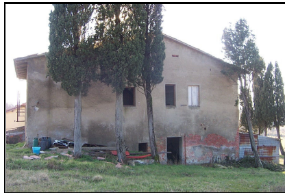
Foto: 08 Data ripresa: 14/02/2006 Edificio: 235/A File: 235-08.JPG
