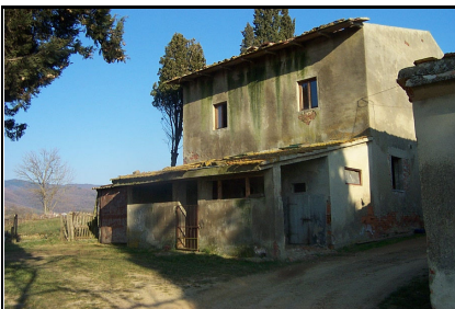
Foto: 10 Data ripresa: 14/02/2006 Edificio: 235/A File: 235-10.JPG
