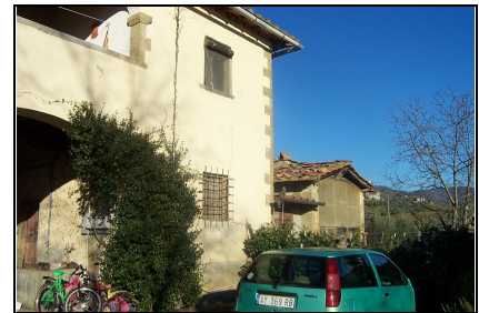
Foto: 06 Data ripresa: 02/02/2006 Edificio: 023/A File: 023-06.JPG
