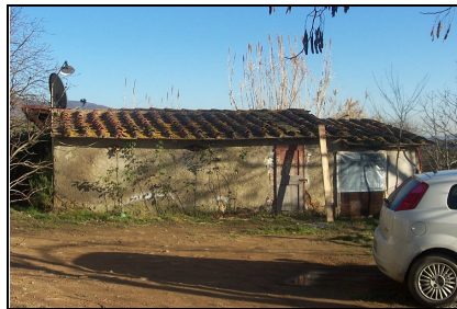
Foto: 05 Data ripresa: 02/02/2006 Edificio: 023/B File: 023-05.JPG
