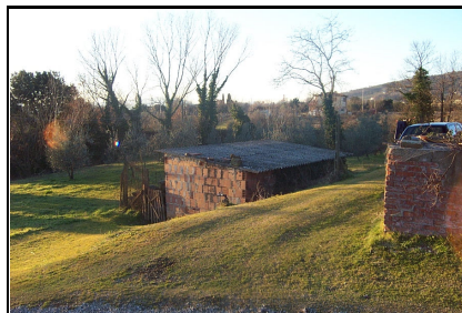
Foto: 11 Data ripresa: 02/02/2006 Edificio: 048/B File: 048-11.JPG
