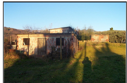
Foto: 09 Data ripresa: 02/02/2006 Edificio: 048/B File: 048-09.JPG
