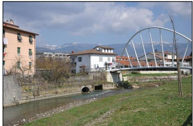
**Foto CI-4** Ciuffenna a valle della passerella S. Giorgio- vista sponda dx (si nota il la discontinuità della quota coronamento del muro spondale esistente).
