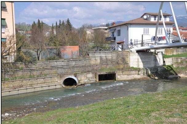
**Foto CI-3** Ciuffenna a valle della passerella S. Giorgio- vista sponda dx (si nota il la discontinuità della quota coronamento del muro spondale esistente).
